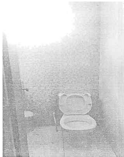
Imagem 8 – Área Sanitária do Avaliando
